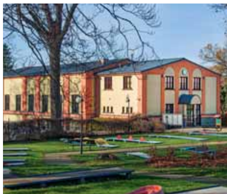
Tělocvična dostala novou střechu
