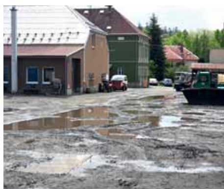
Byla zahájena rekonstrukce sběrného dvora
