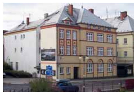
Výměnou oken byla zahájena rekonstrukce bytového domu Masarykova 2
