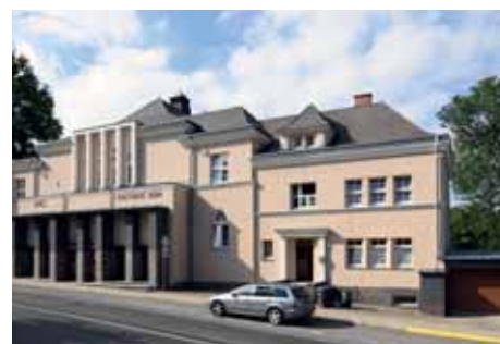
Proběhla obnova fasády kulturního domu
