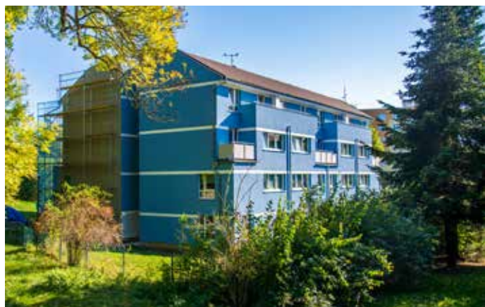
Pokračovali jsme v energetických úsporách našich bytových domů, výměnou oken a komplexním zateplením
