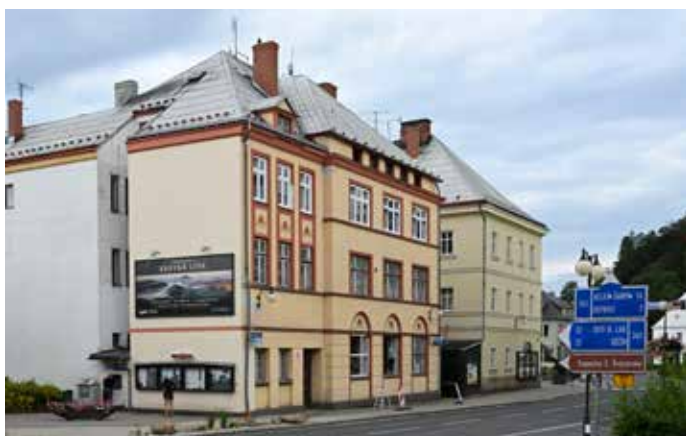
Máme připravenou kompletní rekonstrukci objektu Masarykova 2, kde vznikne 11 nových bytů – začali jsme výměnou oken
