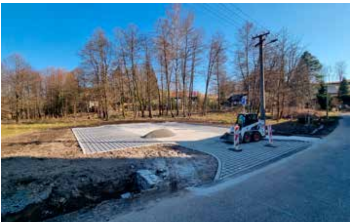
Nově slouží návštěvníkům vybudované parkoviště v Kyjově
