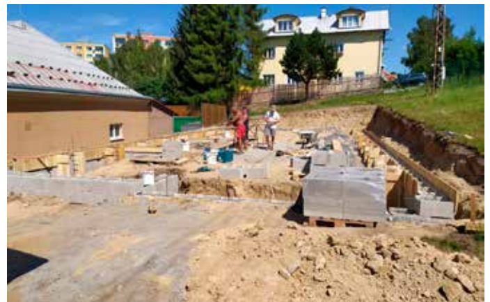
V areálu technických služeb budujeme novou skladovací halu
