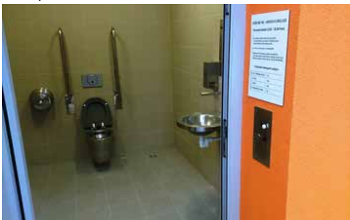
Veřejnosti slouží nové veřejné toalety v zadní části domu služeb
