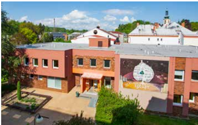
Pokračovali jsme v modernizaci domu služeb - vyměnili jsme okna a část vstupních dveří
