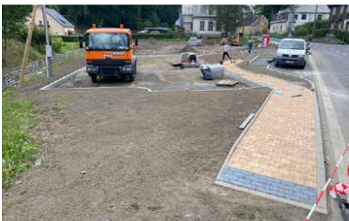
Běží práce na novém parkovišti v Krásné Buce
