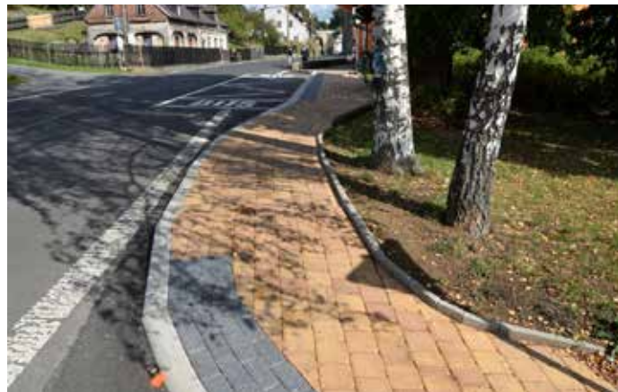
Vybudovali jsme nové chodníky v ulicích Kyjovská, Varnsdorfská a Pražská
